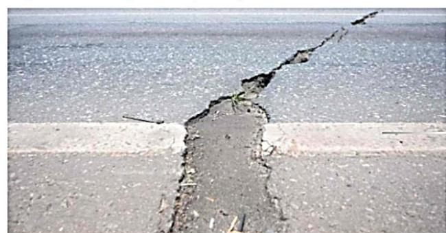
"Ressaltamos que não se trata de uma trinca, e sim de uma junta de dilatação seca do viaduto. Como ela é seca, toda vez que é feito o recapeamento, o mesmo passa por cima dessa junta. E, como a junta de dilatação se movimenta, acaba aparecendo essa separação do asfalto que se assemelha a uma rachadura. No entanto, afirmamos que não é", esclareceu o Dnit em nota.
